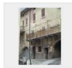
Casa Via Vittorio Veneto 17 Lumezzane (BS)
