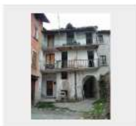
Casa Via Vittorio Veneto 5 Lumezzane (BS)
