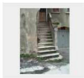
Casa Via Vittorio Veneto 9 Lumezzane (BS)
