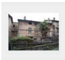
Casa Via Vittorio Veneto 19 Lumezzane (BS)
