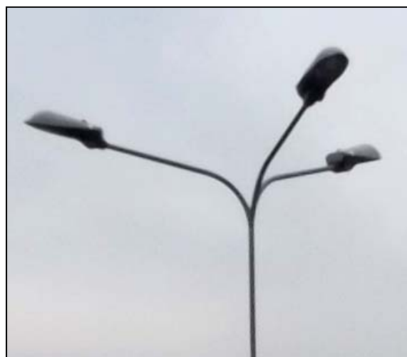
Armature stradali private conformi
