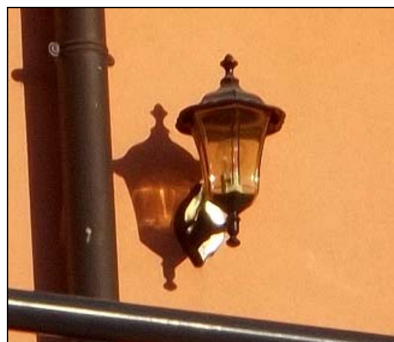
Armatura a lanterna privata non conforme
