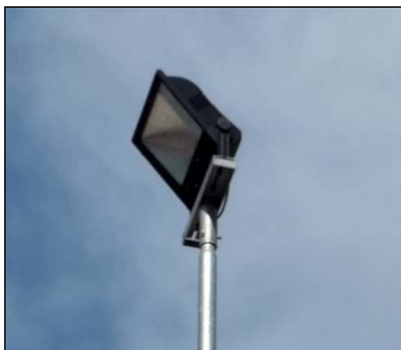
Proiettori asimmetrici privati conformi da orientare
