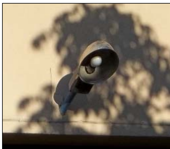
Armatura stradale privata non conforme
