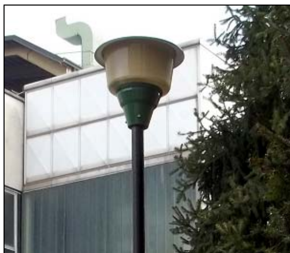
Armatura a fungo privata non conforme
