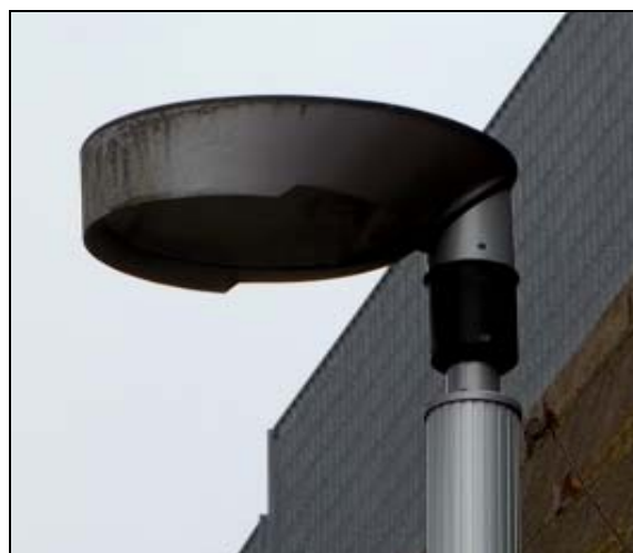
Armatura stradale privata conforme
